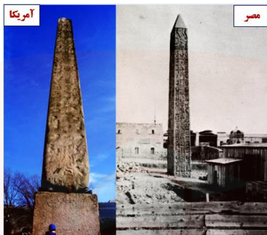
شکل ۱۱: نقش هوازدگی در تخریب سوزن کلئوپاترا
