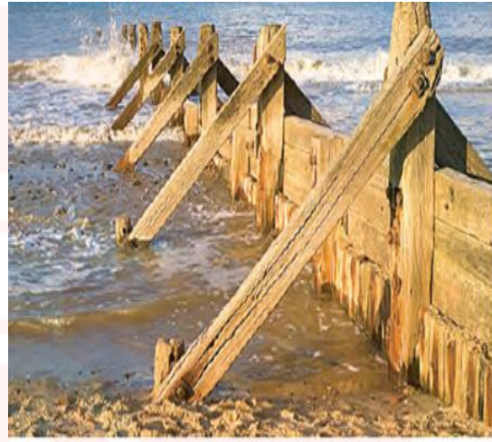
نصب حفاظ عمودی
